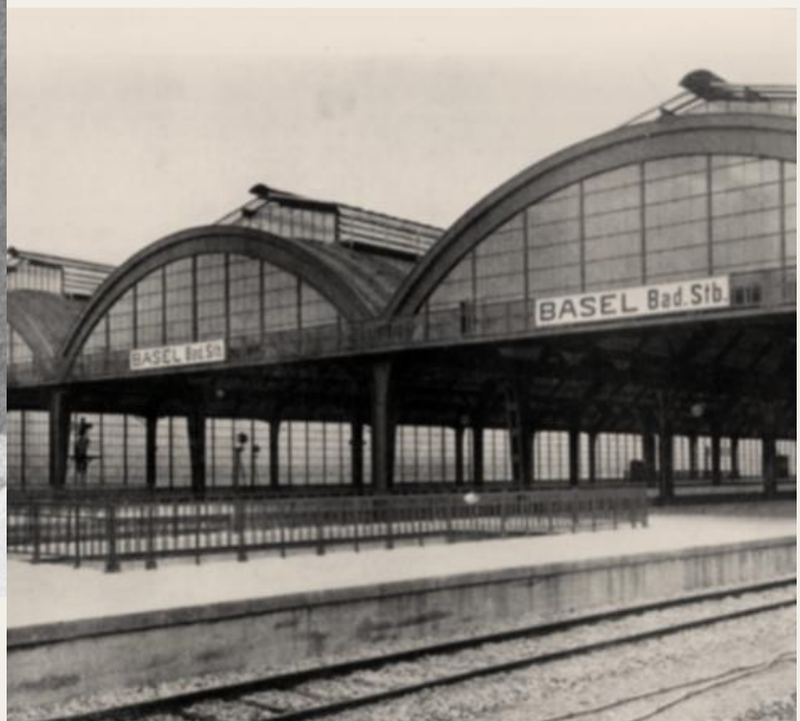
Die Bahnsteighallen 3, 4 und 5 Baukonstruktion: Maschinenfabrik Augsburg-Nürnberg A.-G., Werk Gostenberg. von Nordwesten gesehen. Im Vordergrund: Lichtsack für die Unterführung der Maulbeerstrasse.
