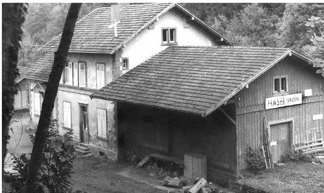
Bahnhof Hasel, Zustand bei der Übernahme
